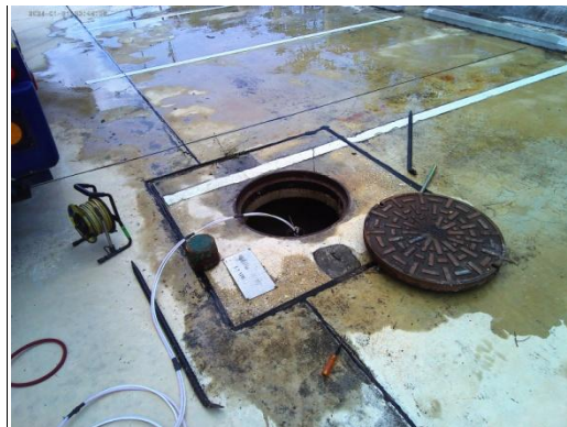
บ่อสังเกตการณ์น้ำใต้ดินตื้นน้ำ ของโครงการโรงผลิตสารโอเลฟินส์ โรงที่ 1/2 (MW02)
